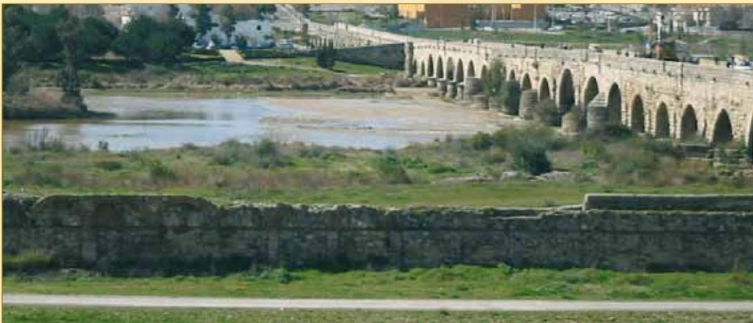
La longitud total del puente es de 769 metros, su altura de 10 metros. El ancho de los arcos de 6,40 metros y el ancho de los pilares donde se apoyan los arcos de unos 5 metros.
