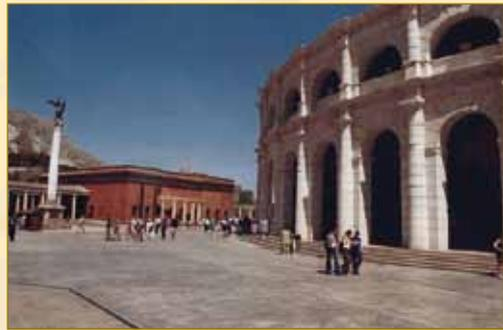
Aunque tiene forma elíptica, a la vista parece que sea un círculo pues mide 188 metros de largo y 156 metros de ancho. La altura de su anillo exterior es de 50 metros (unos 15 pisos). Se utilizaron 10.000 metros cúbicos de mármol travertino para recubrir la fachada y 300 toneladas de hierro para fabricar las grapas que unían los sillares.
